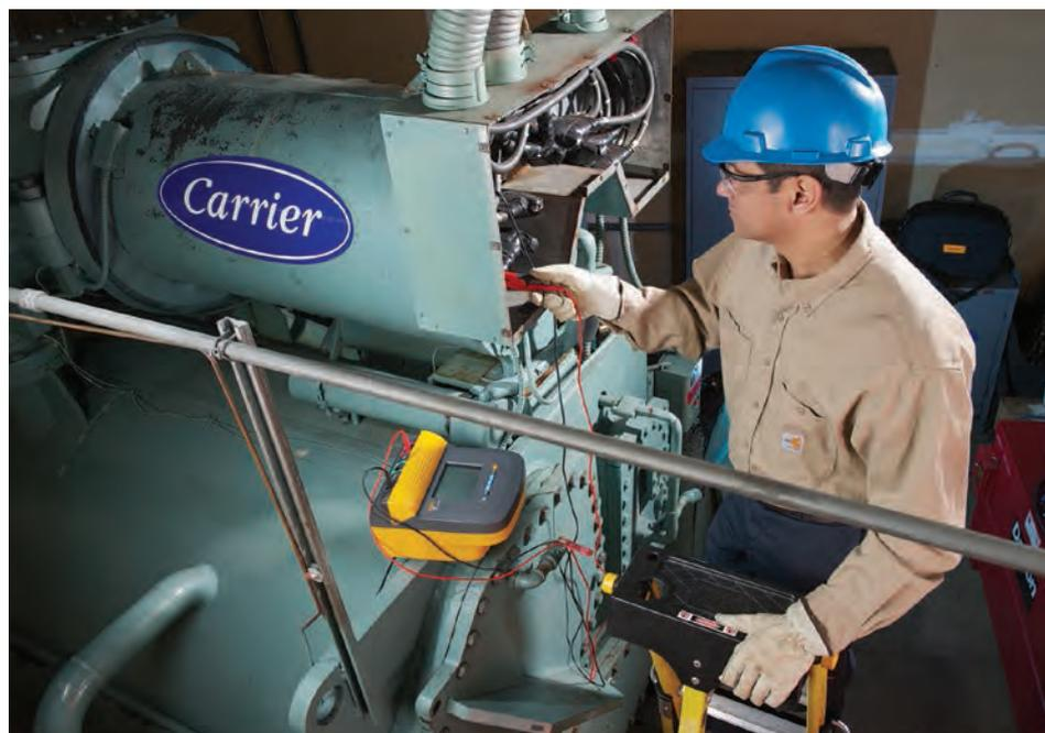
метра (DMM). Необходимо убедиться в отсутствии напряжения во всех цепях и оборудовании до того, как тестер сопротивления изоляции будет подключен к оборудованию. Поэтому часто бывает неудобно перемещать одновременно DMM для испытания напряжения и тестер сопротивления изоляции к разным участкам.
